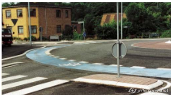
Figur 2: Exempel på färgade ytor med cykelsymbol för att tydliggöra gällande väjningsregler. Källa: (Vejdirektoratet, 2000: sid 91)
