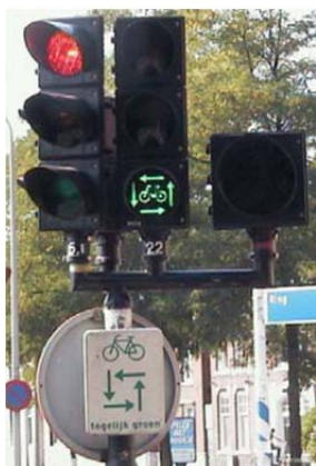
Figur 21: Signalstyrd allcykelfas. Källa:( Zeegers, 2004)
