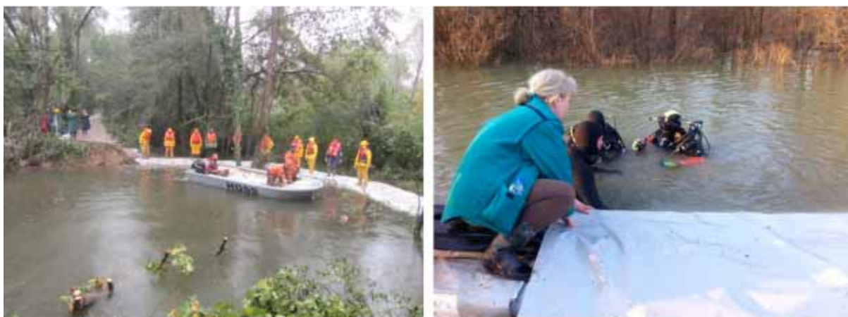
Slika 61. Pomoć HGSS-a na zatvaranju prodora nasipa (Letovanić) i ronilaca na sprečavanju procjeđivanja nasipa (Puska)
