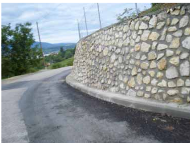
Slika 11. Potporni zidovi od lomljenoga kamena (Soldo, 2010)
