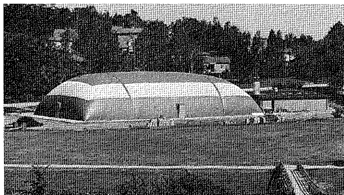
Fig :131f. Pneumatiskt membran för badanläggning (35×17 m) med transparent band runt om
