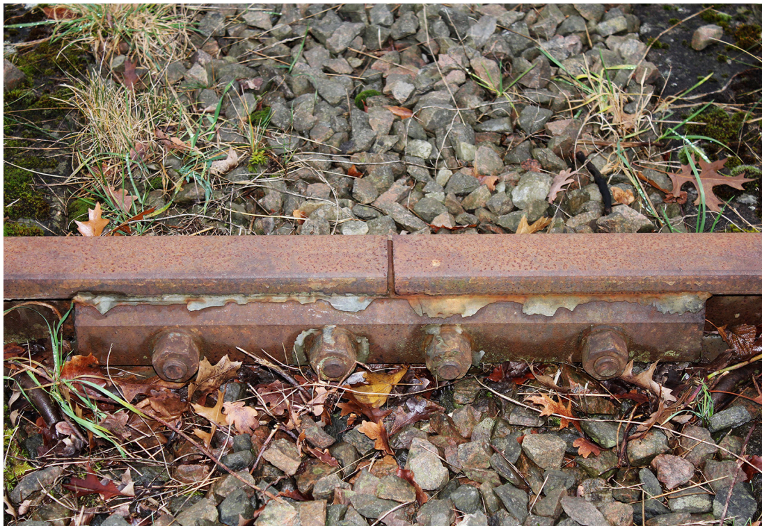
Rällskarv med skarvjärn. Banan Lund-Trelleborg som lades ner 1960. Fram till 2015 använde Tetra Pak i Lund en kort sträcka för godstrafik. Foto: Patrik Sandgren.
