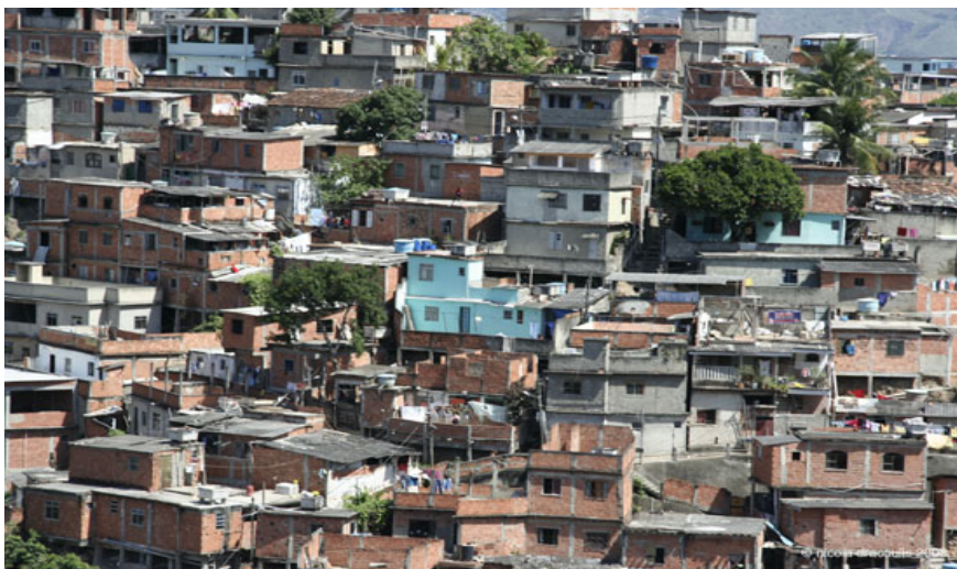
Kåkbostäder som byggdes upp efter tsunamikatastrofen 2004.
