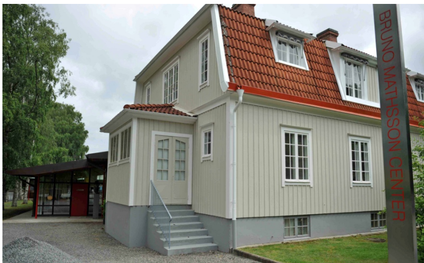
Bruno Mathsson Center i Värnamo. Byggnaden där Bruno Mathsson hade sin produktion och där företaget fortfarande har sin verksamhet. Se även ovanstående bild.
