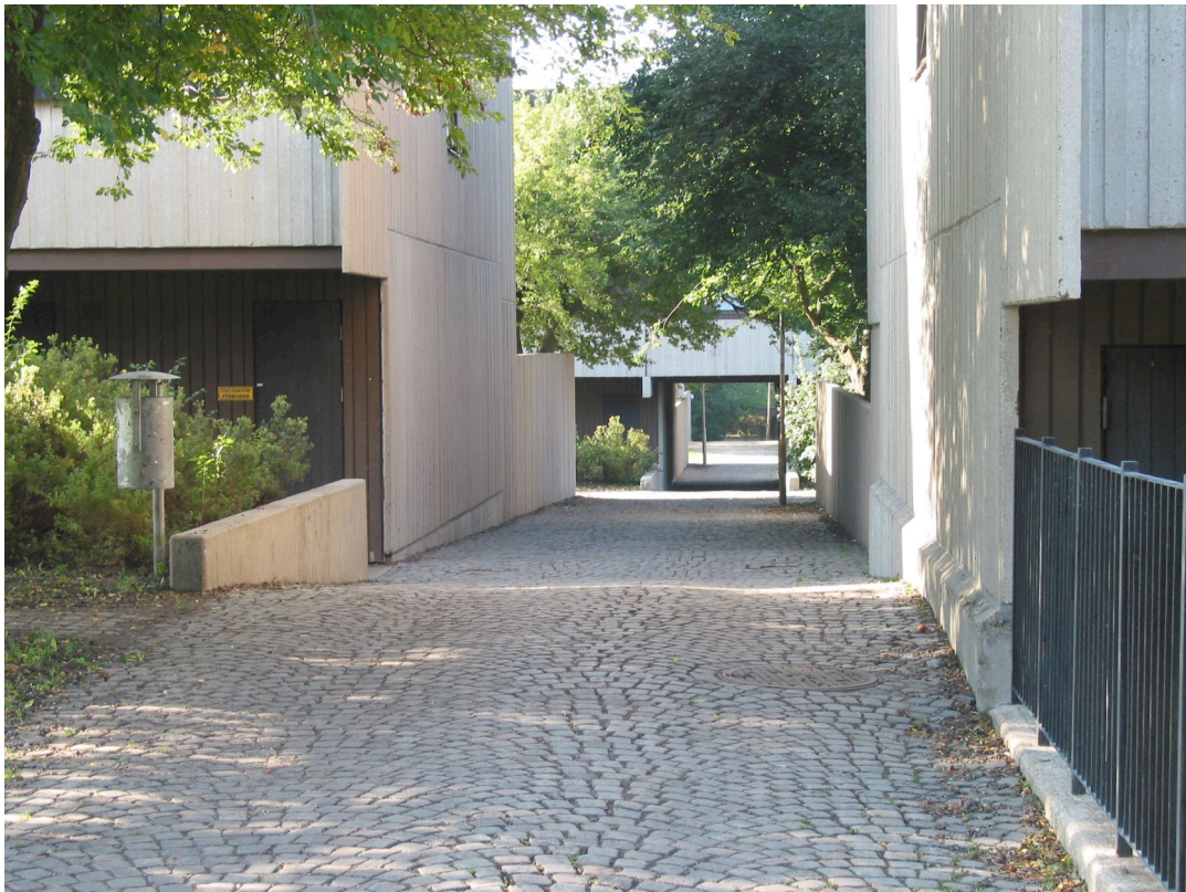
Bild 4. Huvudgångstråk mot sydväst, lamellhusdelen.
