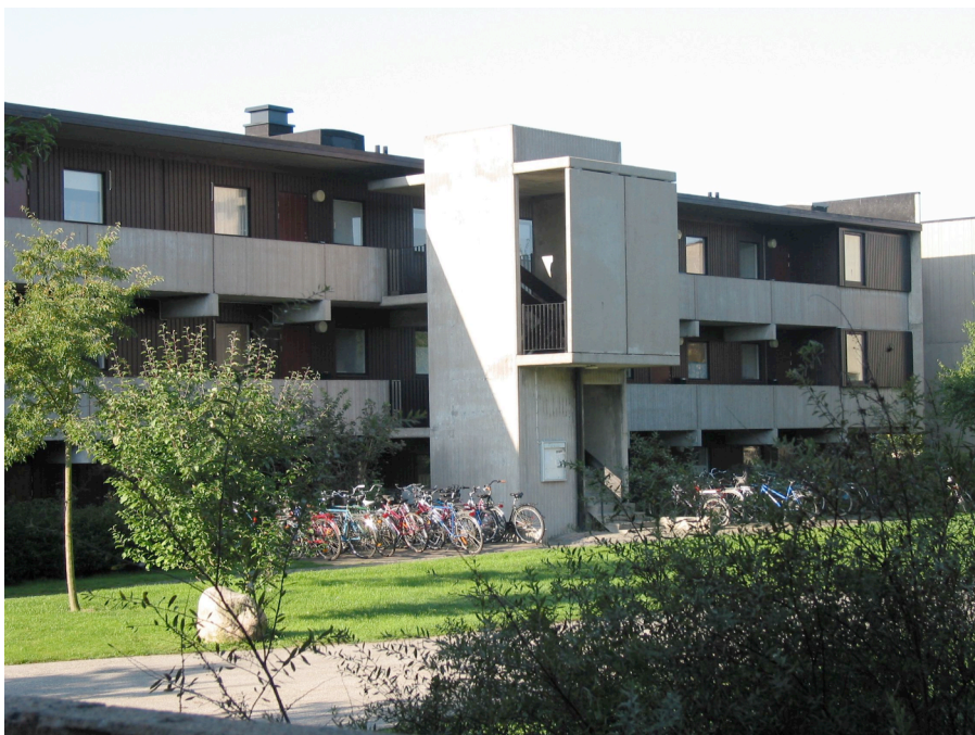
Bild 2. Lamellhusen, fasad med trapphus.
