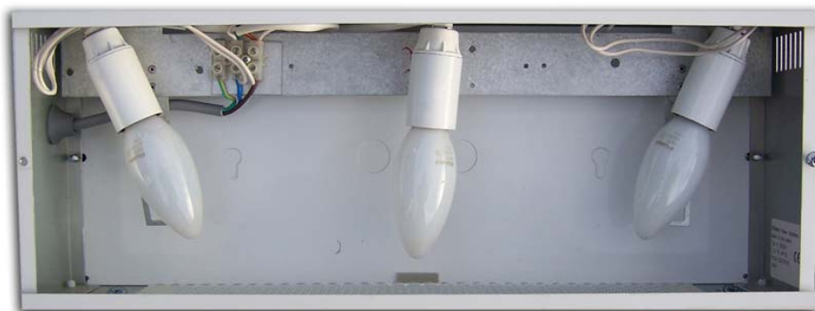
Figur 4:1 Tre stycken kronljuslampor monterade som ljuskällor i utrymningsskylten.
