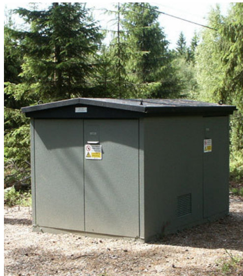
Figur 1.1 Nätstation i det luftburna nätet (Källa: Andersson, Mats, (2006-04-19))
