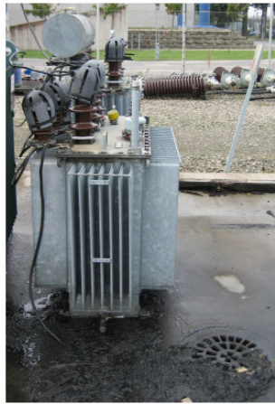
Figur 5.9 Oljegrop på ElektroSandberg driftsförråd i Malmö
