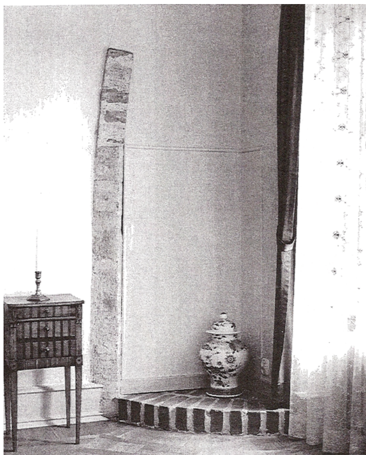
Fig. 18. Rest av originalspis från 1534 i den östra lägenheten i gavelrummet på ovanvåningen (Romberg & André, 1993:21).
