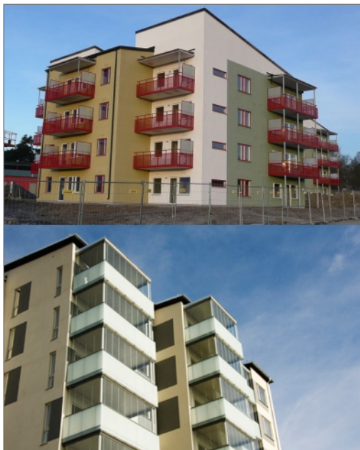
Komplettprojekt, Kaptensv. och Strandgatan
