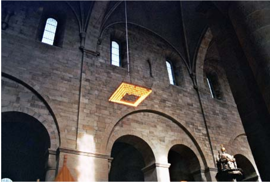
Fig. 28. Mittskeppet efter Graebes restaurering.
