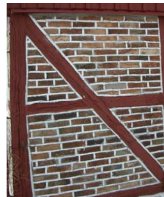
Bild 4. Murad tegelvägg mellan stolparna. Skånelänga Fjärestad.
