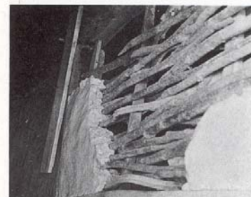
Bild 3. Uppbyggnad lerklinevägg. Så renoveras torp och gårdar, ICA förlaget.
