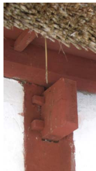
Bild 2. Närbild av anslutningen mellan takbjälkar och stolpar. Foto. Skånelänga Himmelstorpsgården
