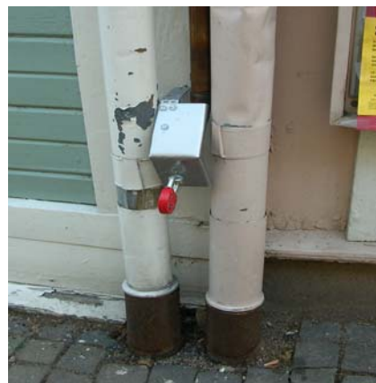
Bild 2 och 3 Vänstra bilden visar sektionering och högra visar anslutning av vattenförsörjning till loftsprinkler.
