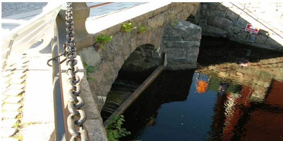
Bild 5 Fördämning av ån.
