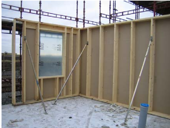
Bild 8.3 Infästning av ytterväggsselement i betongplattan
