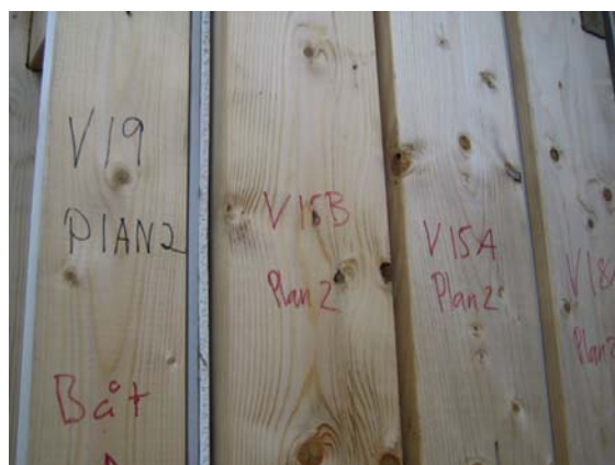
Bild 8.2 Markering av väggelementen
