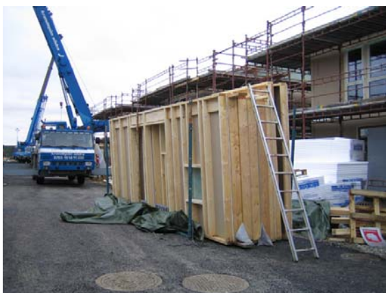
Bild 8.1 Kranbil för montage och häck med väggelement
