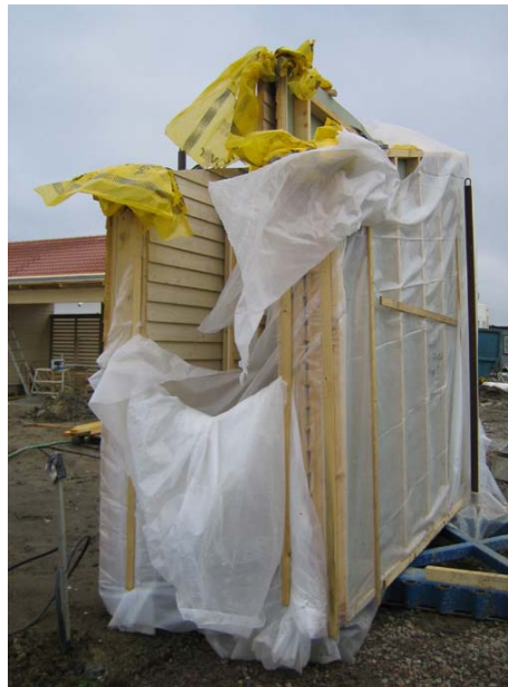
Bild 8.6 Häck med byggelement på byggarbetsplatsen
