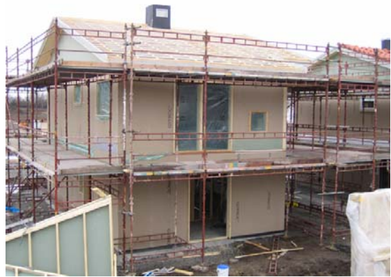
Bild 8.4 Färdigmonterad stomme och tätt hus
