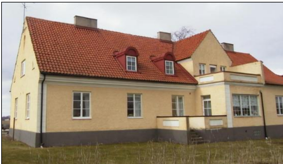
Bild 9: Borby kungsgård , ryttmästare Borby skvadron SDR. Den vänstra delen är karaktärshuset från 1754, byggt i sten enligt 1731 års ritningar och väl dolt i en stor tillbyggnad från 1870-talet. Detta är baksidan. Den gamla entrén är igensatt. För hallen till den nya huvudentrén har två av de gamla kamrarna tagits i anspråk.
