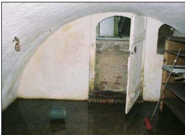
Bild 15: Vattnet står högt i Hjälms Hulstas källare, ett resultat av en igenmurad dörr. Foto förf mars 2005.
