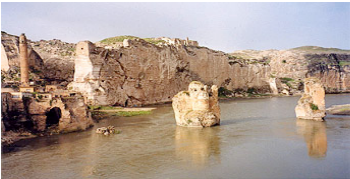
Fig. 16 Resterna av Tigrisbron, avståndet mellan pelarna är hela 40 meter (Turkeyvision hemsida).
