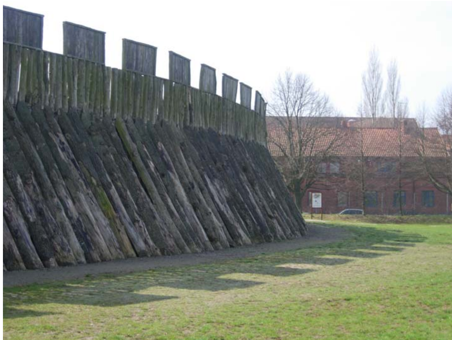
Bild 1. Trelleborgen med "trelleorna" som utgör en karaktäristisk del av trelleborgarnas träkonstruktion. Foto: T.Widerberg ©
