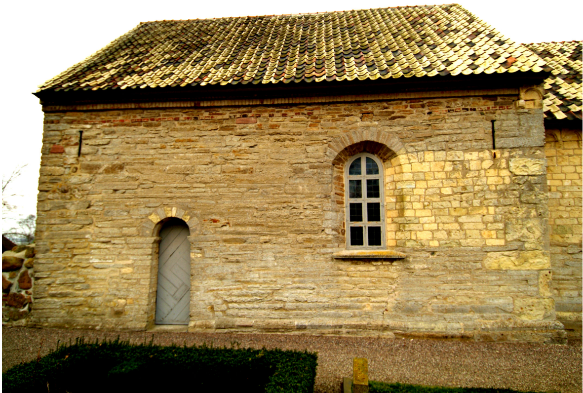
Figur 4 Långhusets södra mur. Foto Erik Johansson 2007
