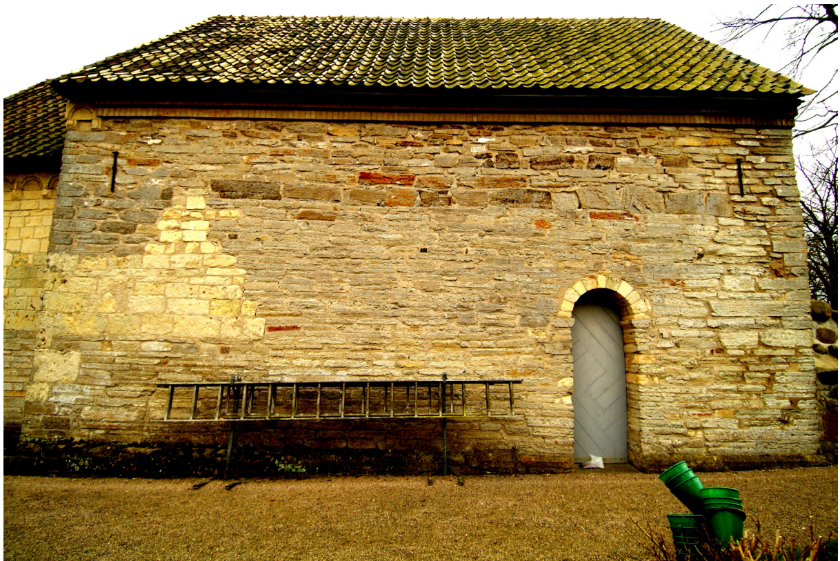
Figur 7 Långhusets norra mur. Foto Erik Johansson 2007
