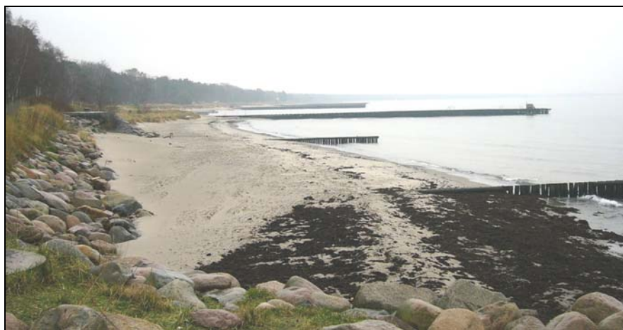
Figur 3.6 Två erosionskydd i det studerade området. En hövd som sträcker sig vinkelrätt ut från stranden samt stenskoning längs klittret.
