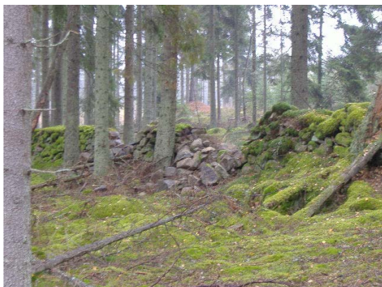
Figur 4. Skadad gårdsgård på grund av träd som fallit. Foto Jeanette Ohlin
