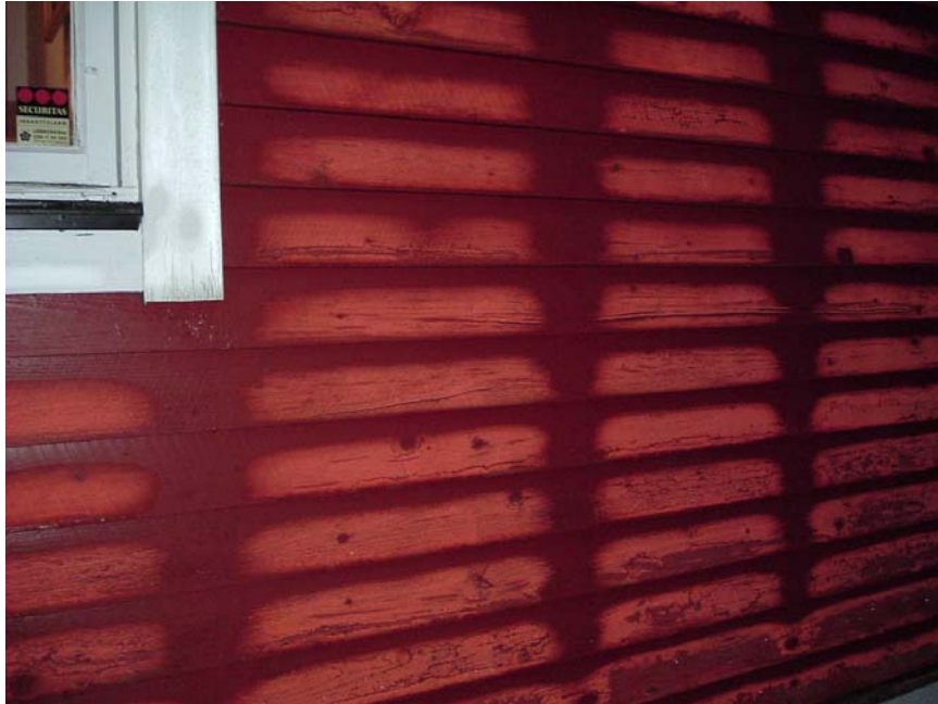
Figur 2.4. Delvis frosttäckt husfasad med ojämnt värmegenomgångstal [eget material].
