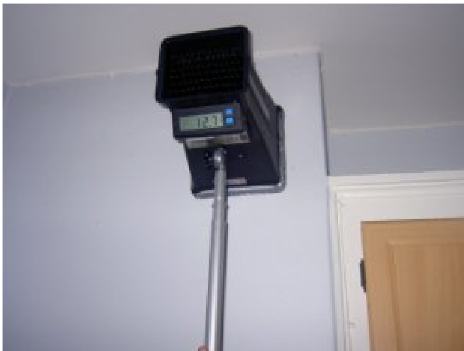
Figur 4.2. Mätning av ventilationsflöde på Davidhallstorg 10, mätaren visar flödet 12,7 l/s [eget material].
