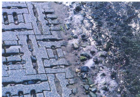
Figur 3.8. Flexplattor, som är dränerade betongplattor (Hagström, 2001).
