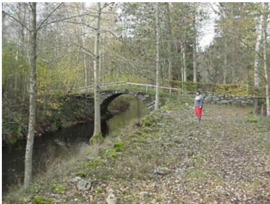
Figur 6: Bron som på 1880-talet byggdes i rågången av Sågmölleplanen uppströms Ekeshultsån. Fotot är taget mot väst-nordväst. (Foto: Rolf Bengtsson, oktober 2000)
