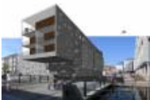
Projekt, Västra hamnen, Malmö, http://www.ncc.se
