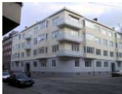
Slottstaden, Malmö AC, Arkitekt Axel Carlsson AB http://www.ark-ac.se/fasad.htm Se internetkälla.
