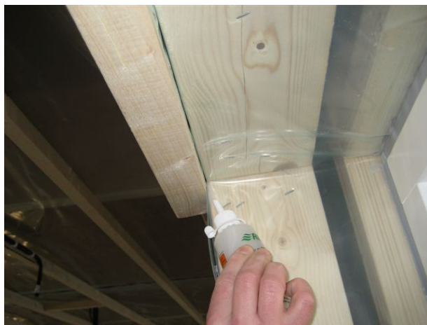
Figur 3.2 Undersökning av läckor med hjälp av rök.
