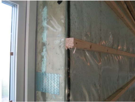
Figur 3.5 Bilden visar att lösullen inte kommer mellan reglarna.
