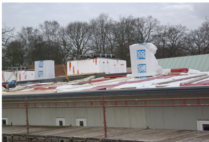
Figur 3.1 Takpappen sätts på plats.
