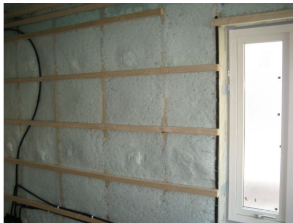
Figur 3.4 Vägg fylld med lösull.
