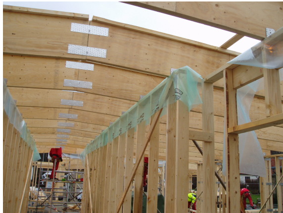
Figur 3.6 Uppbyggnad av kertobalkarna. Plastfolien ovanpå bärande vägg är lagd för att plastfolien skall kunna föras fram kontinuerligt i tak. Skarvarna klistras sedan ihop.
