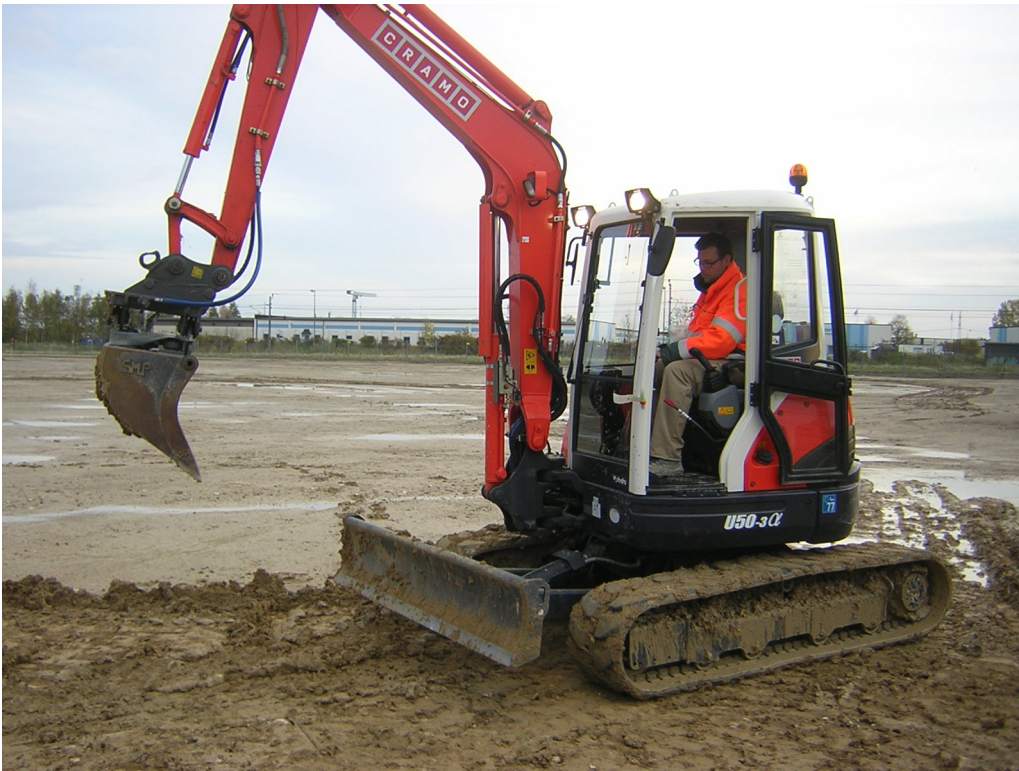
Figur 5.3 Bortskrapning av lervälling med minigrävmaskin.
