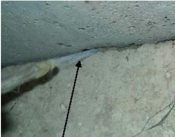
Figur 6. Bilden visar nere från en krypgrund hur indikeringsröken tränger ner genom en Bjälklagsanslutning.
