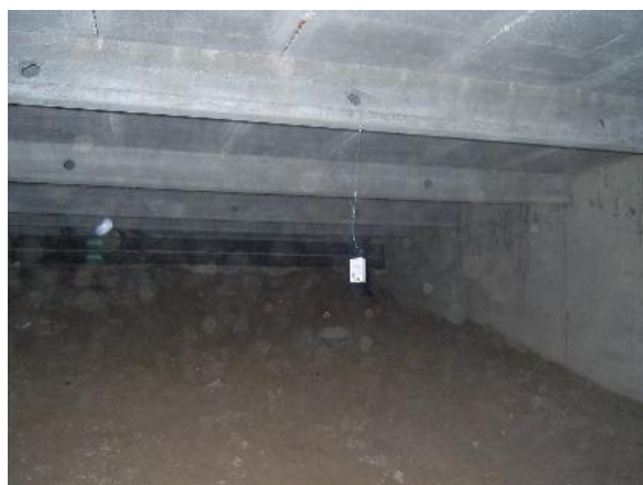
Figur 9. Mätinstrument utsatt hängandes i krypgrund
