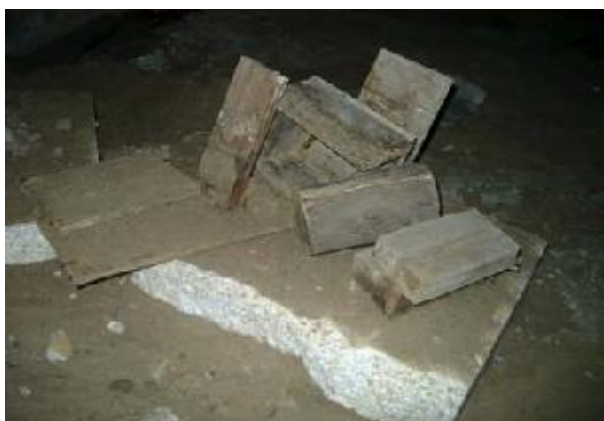
Figur 5. Insamlat byggspill från krypgrunderna.
