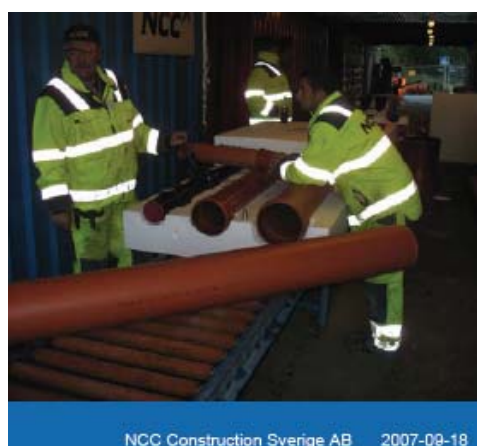
Figur 13. Figuren visar hur rören läggs ner i cellplastblocket i samma höjd, för att sedan transporteras till anläggningen. Allt detta görs på fältfabrik. (Fotot hämtat från NCCs broschyr om Skogs Ekeby)
