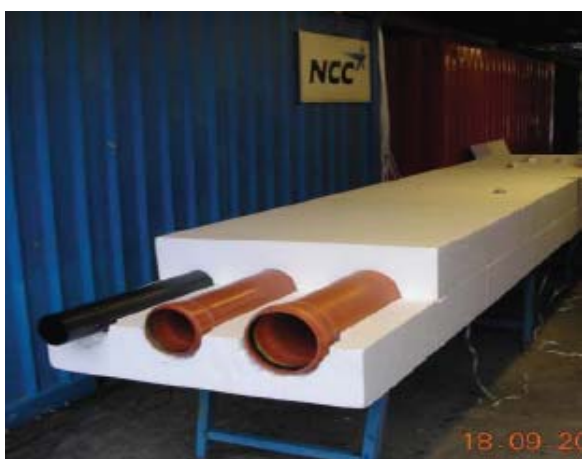
Figur 13. Figuren visar hur rören läggs ner i cellplastblocket i samma höjd, för att sedan transporteras till anläggningen. Allt detta görs på fältfabrik. (Fotot hämtat från NCCs broschyr om Skogs Ekeby)
