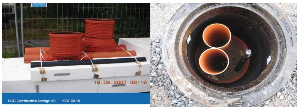
Figur 12. Plastringar på cellplastblocket samt en integrerad brunnslösning för den nya modulen (Det vänstra bilden är från NCCs broschyr om Skogs Ekeby och högra bilden är tagen i Skogs Ekeby projekt). Högra Foto: Christian Cruz
