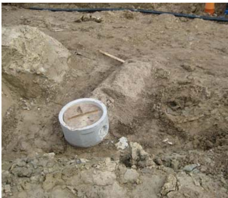
Figur 6. Bilden visar en ny dagvattenbrunn som har lagts på Annehemsprojektet, Lund. Foto: Christian Cruz
