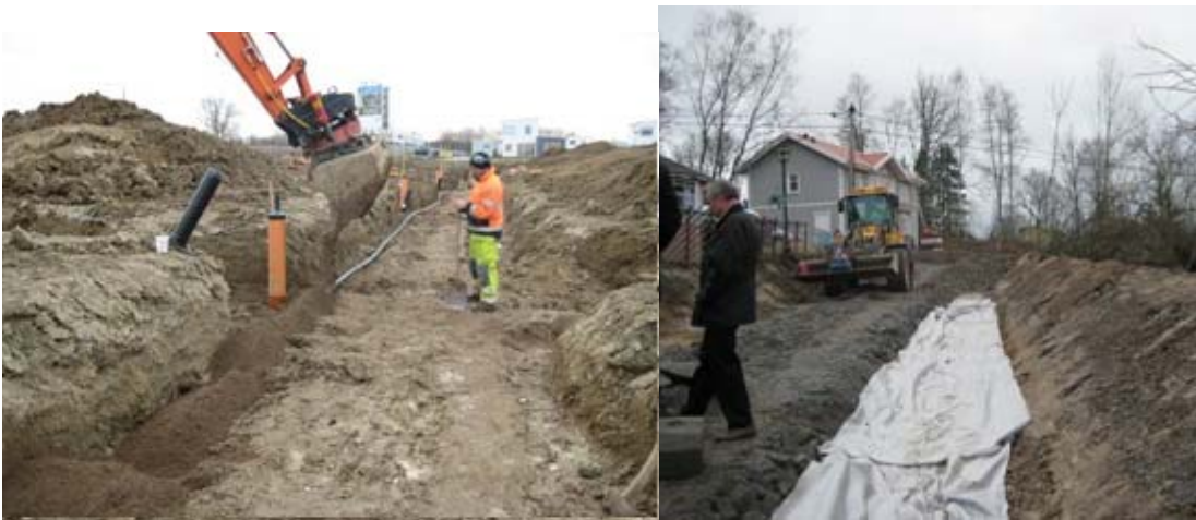
Figur 17. Här ser man skillnaderna på utseende av ledningsbredd för respektive metod. Vänstra bilden är tagen i Annehems projekt och högra bilden är tagen i Skogs Ekeby projekt. Foto: Christian Cruz
