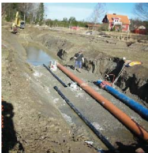
Figur 15. Bilderna visar skillnaderna på utrymmen man behöver för att lägga rörarna (Fotot hämtat från NCCs broschyr)
