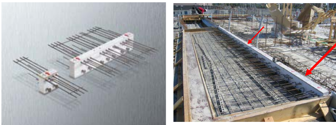
Figur 5.13 Till vänster visas infästningsmodulen HIT, som kan sågas till önskade längder på plats. Till höger visas en fritt utkragande balkong som är försatt med HIT-moduler för inspänning till bjälklag (bilderna är hämtade från HALFEN-DEHA AB:s hemsida).
