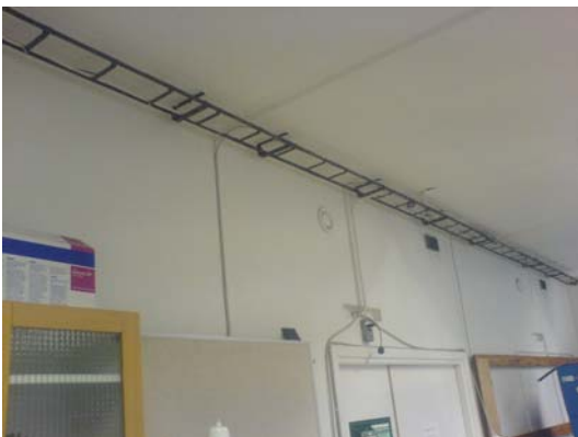
Väggen där mätningen utförts
