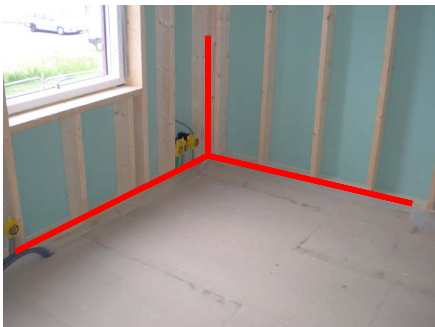
Linjen markerar IR-mätningen på övervåningen
