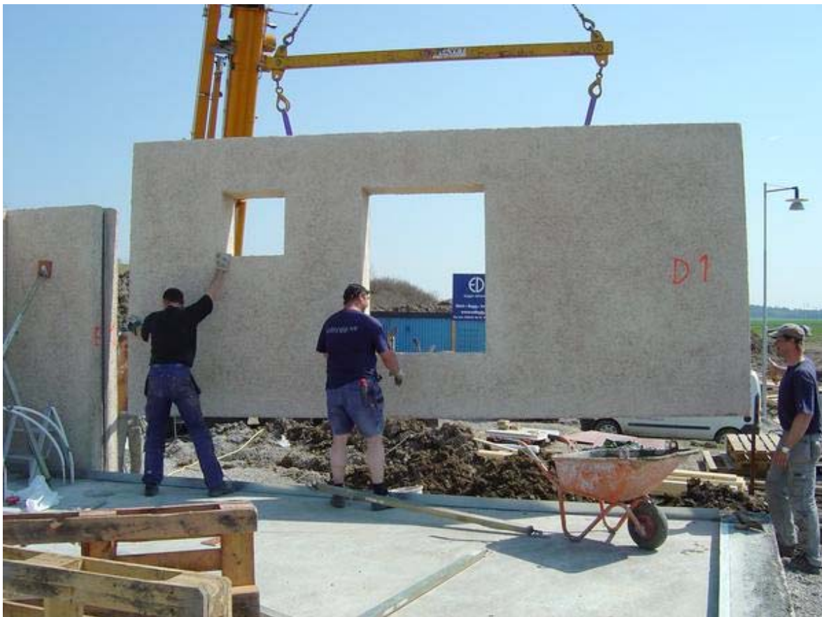
Figur 3-1 Resning av helväggselement i träull. Bild från traullit.se
