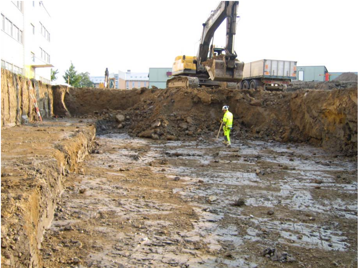
Figur 10. Schakt med grävmaskin på Skanskas projekt i Lund. Yrkesarbetaren kontrollerar höjden på terrassen med en plan laser.
