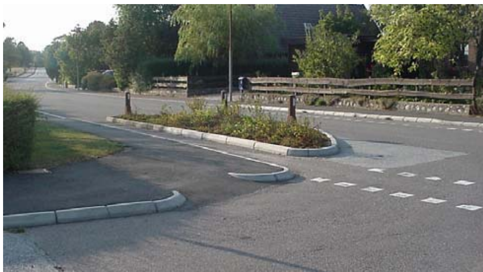
Figur 5.4 Sidoförskjutningar, korsningen Norra Fäladsvägen/Backvägen västerut
