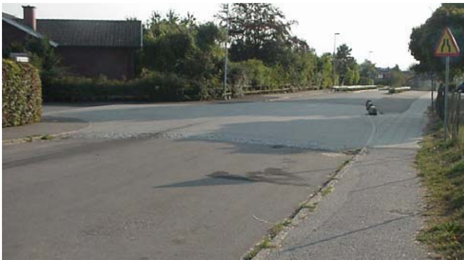
Figur 5.19 Upphöjd korsning Idrottsvägen/Vallmovägen, söderut
