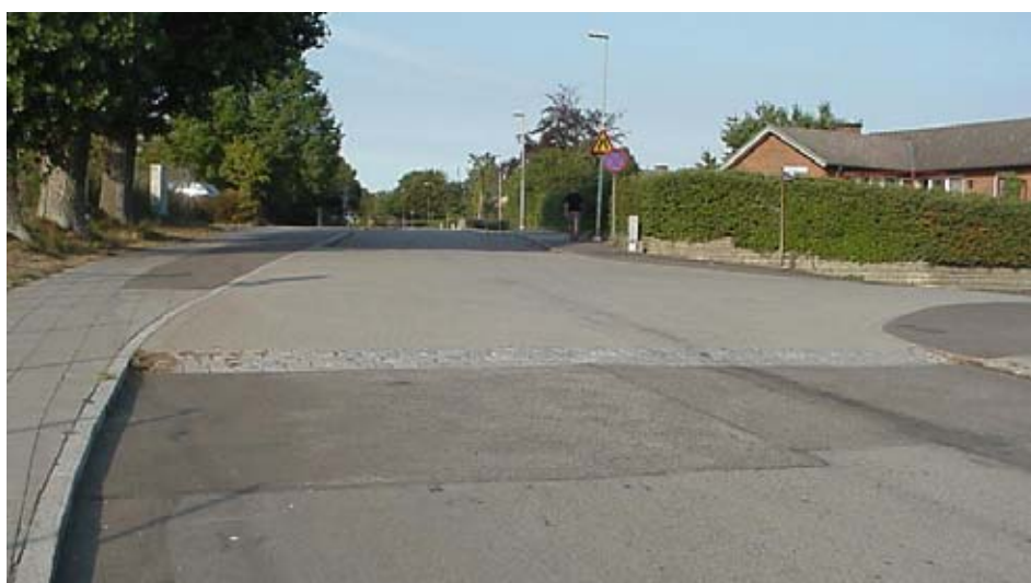
Figur 5.18 Upphöjd korsning Idrottsvägen/Långgatan, norrut
