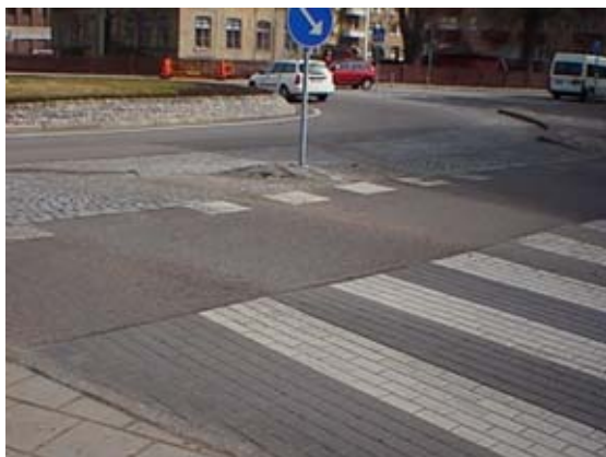
Figur 24. Stensättning av övergångsställe och cykelöverfart på Erikssgatan söderifrån.
