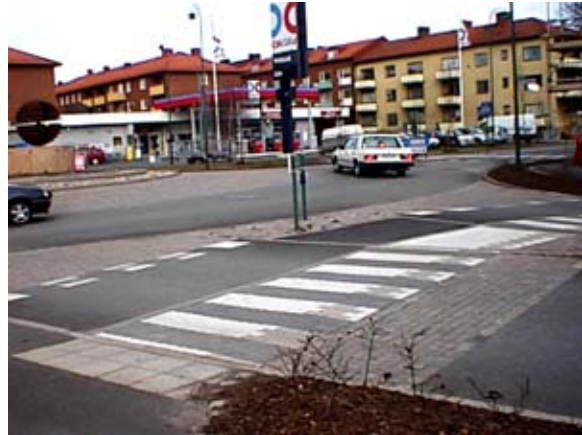
Figur 17. Södra övergångsstället med stensättning.
