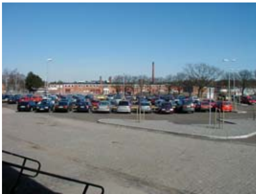
Parkeringen är nybyggd men är konstigt nog inte asfalterad
