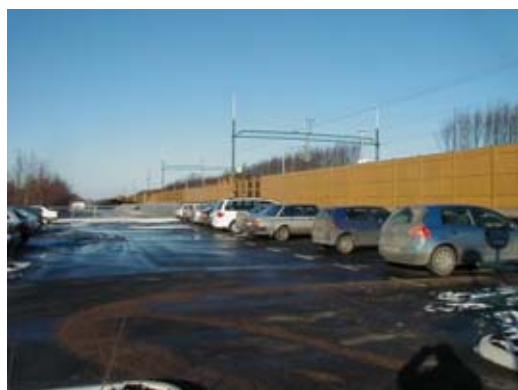
Parkeringen är avskärmd från spåret med ett högt plank
