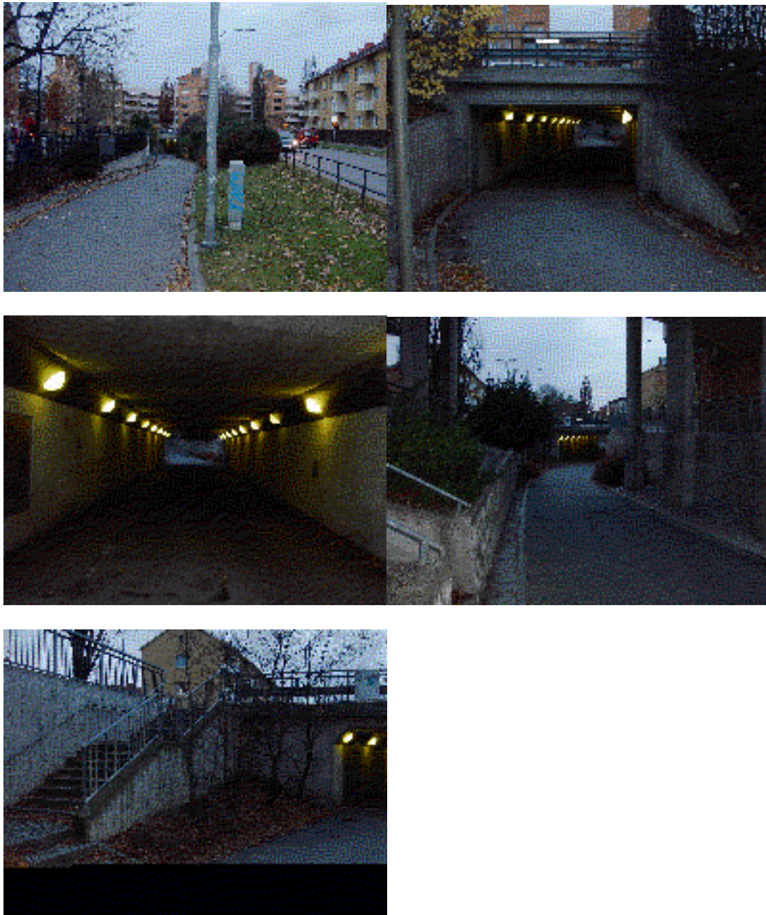
Figur 4.10 Gång- och cykeltunneln i Västerås
