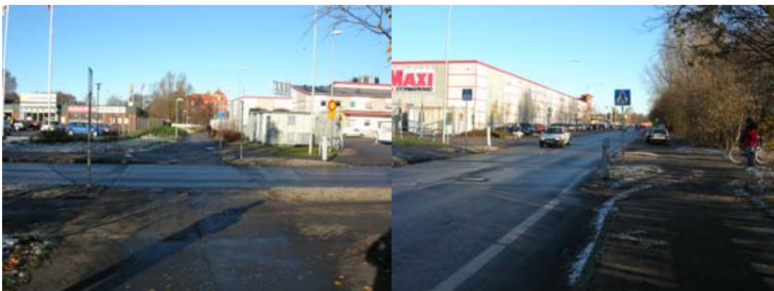
Figur 4.22 Västra övergångstället på Regementsvägen i Helsingborg efter ombyggnaden.
