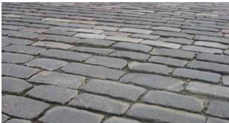
Figur 5.21. Ojämn beläggning på Stortorget.
