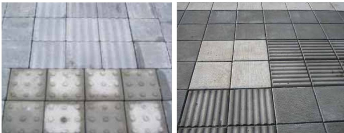
Figur 2.7. Exempel på taktila plattor. Till vänster visas kupolplattor som övergår till sinusplattor. Till höger visar sinusplattor som byter riktning med hjälp av en kontrastplatta (Ståhl et al, 2004; Eskilstuna kommun, 2006).
