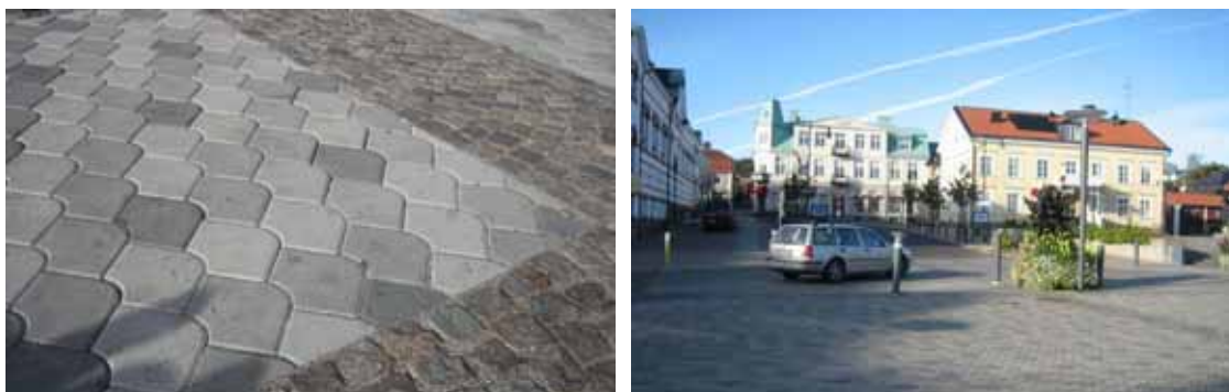
Figur 5.3. Till vänster visas beläggningsen; betongstenen som representerar "fiskfjäll" i tre olika nyanser samt inramningen med smågatsten. Till höger visas möbleringen på Fiskaretorget, där fordonen styrs av blomsterarrangemang, belysningsstolpar och belysta pollare.
