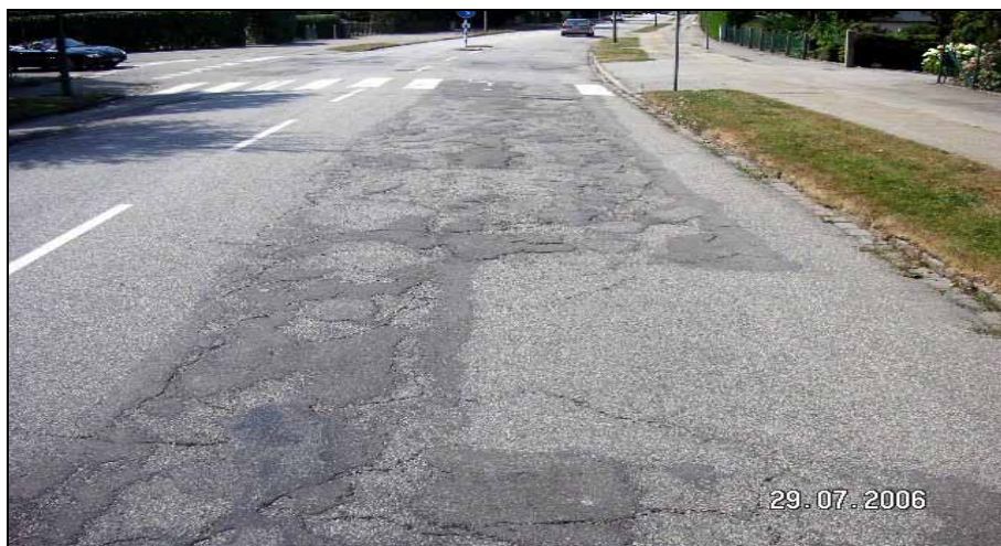
Figur 4.7. Exempel på lagringar i de krackelerade områdena
