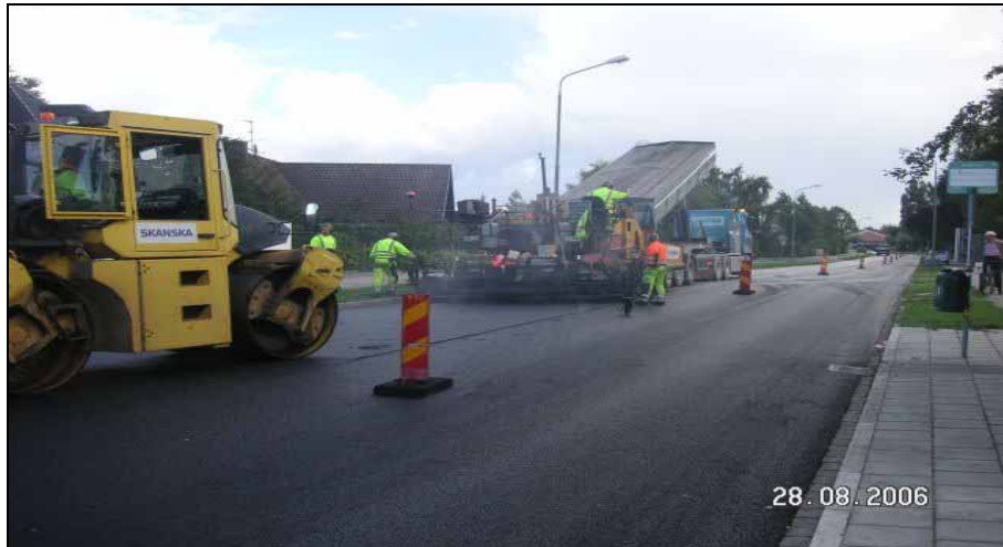
Figur 7.2 Laggning av asfalt på Ellenborgsvägen
