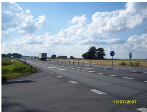
Figur 4.20 Öppningar i mitträcket är 6 meter breda för traktorer (Foto: Zainab Mousa)
