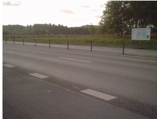
Figur 4.6 Mitträcke efter genomförandet. (Foto: Zainab Mousa)
