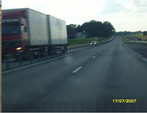
Figur 4.4 Väg 21 efter ombyggnaden, blev säkrare med mitträcke (Foto: Zainab Mousa)
