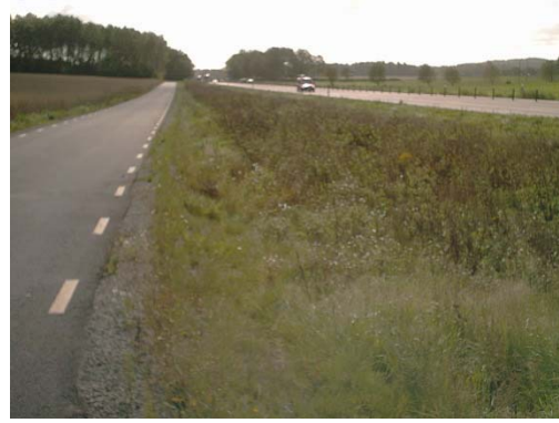
Figur 4.8 Väg 21 efter ombyggnaden, vid Lommarpskorset (Vägverkets arkivbild)
