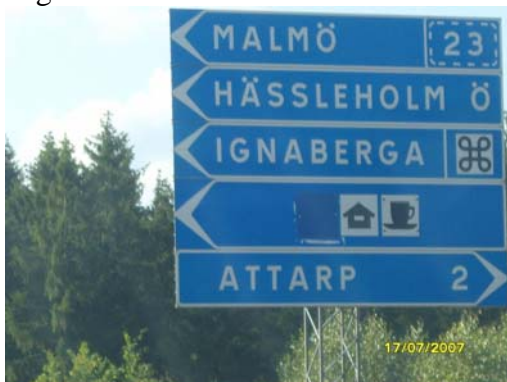
Figur 4.19 Vägmärken är av strängpressad aluminium och högreflekterande
