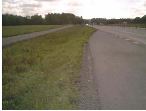
Figur 4.10 Väg 21 efter ombyggnaden av parallellvägen för oskyddade trafikanter och långsamgående fordon. (Foto: Zainab Mousa)
