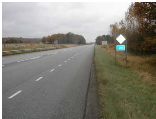
Figur 4.2 Väg 21 före ombyggnaden, smal och utan mitträcke.(Vägverkets arkivbild)
