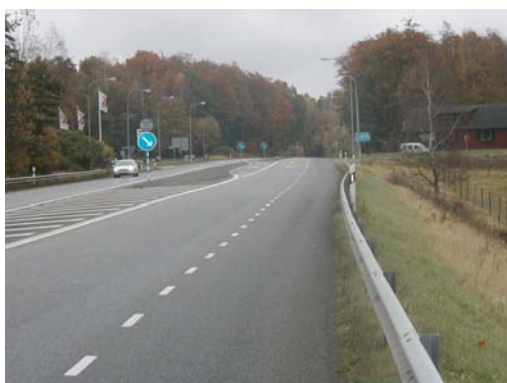
Figur 4.1 Väg 21 före ombyggnaden, trafikön för vänstersvängande på den smala vägen (Vägverkets arkivbild)
