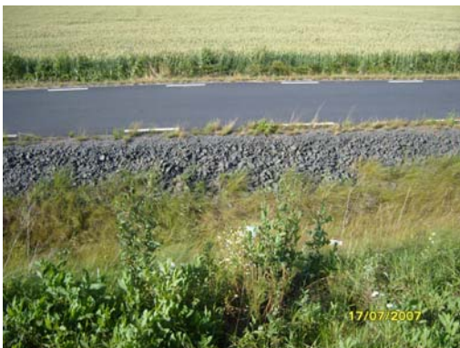
Figur 4.27 lutning på innerslänt är 1:3 Släntslutning mot väg 21 varierar (Foto: Zainab Mousa)
