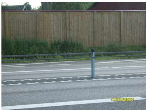
Figur 4.21. Inspänt ställineräcke som mitträcke (Foto: Zainab Mousa)
