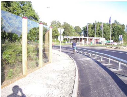
Figur 4.7 Väg 21 efter ombyggnaden med parallellvägen för GC-trafik och långsamgående fordon, det ligger vid sidan av huvudvägen inom intervallet 5-10 m (Foto: Zainab Mousa)
