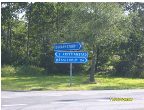
Figur 4.29 Vägmärken är strängpressad aluminium och är högre reflekterande (Foto: Zainab Mousa)
