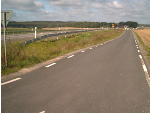
Figur 4.9 Väg 21 efter ombyggnaden med parallellvägen för oskyddade trafikanterna (Foto: Zainab Mousa)
