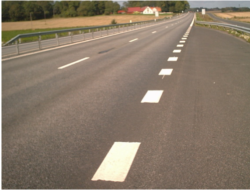
Figur 4.3 Väg 21 efter ombyggnaden, (Foto: Zainab Mousa)
