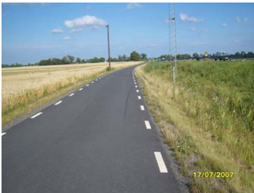
Figur 4.17 lutning på innerslännt är 1:3 Slänslutning mot väg 21 varierar (Foto: Zainab Mousa)
