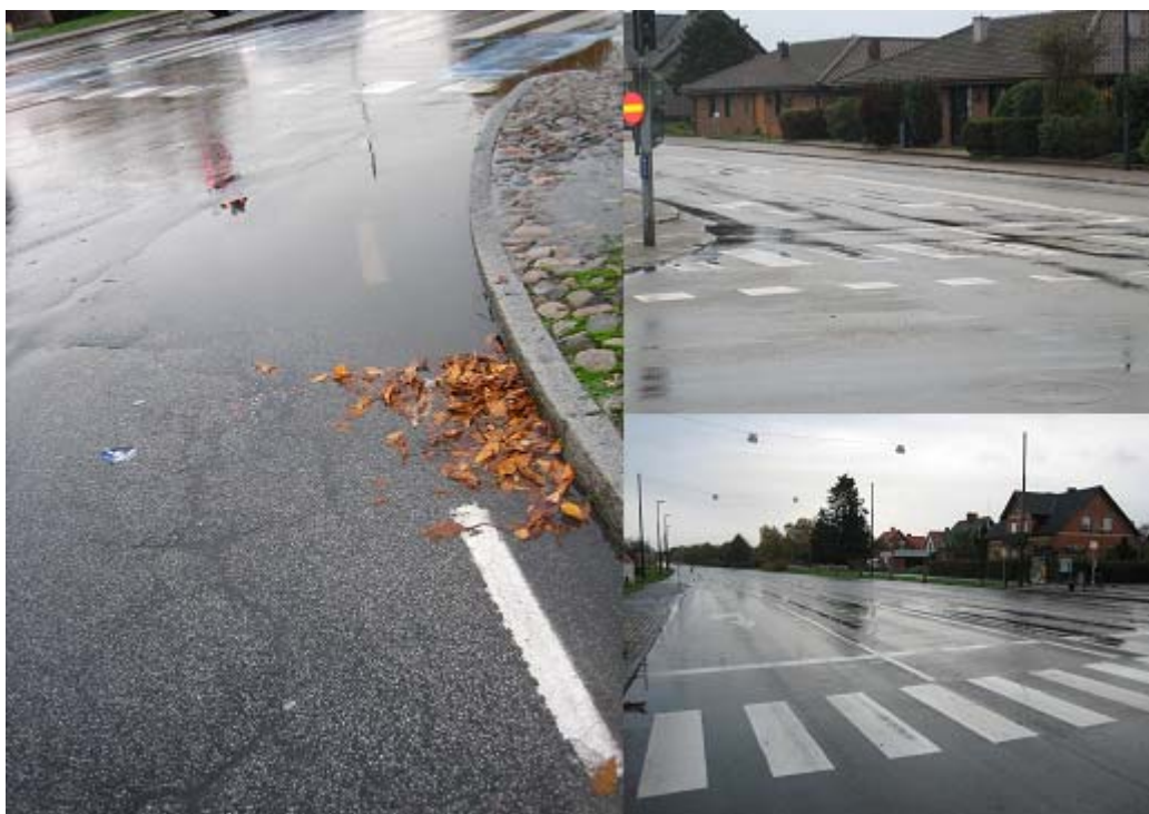
Figur 6.12: Korsning med dålig ytvattenavledning. Till vänster: Vattensamling längs kanten inne i korsningen. Uppe till höger: Vatten stående på vägbanan i Västra Skrävlingevägens tillfart. Nere till höger: Vatten på vägbanan i Sallerupsvägens tillfart. (Foto: Mårtensson, Wilén)
