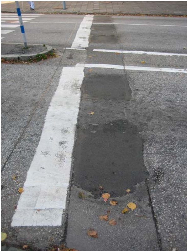
Figur 6.13: Visar lappning och lagning på Drottninggatan norrifrån i korsningen Drottninggatan – Östra Förstadsgatan. (Foto: Mårtensson, Wilén)
