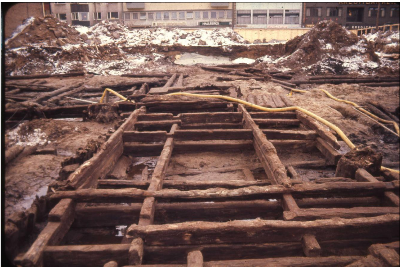
Figur 9. Grundläggingskistor i kvarteret Abisko 1980. Foto: Jönköpings läns museum.
