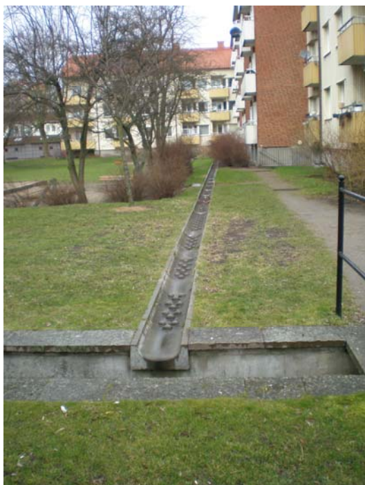
Figur 20. Avrinning med hjälp rännor på Augustenborg. (Bringert & Nordwall, 2009).
