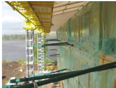
Figur 14 Väderskyddets stagnering mot vägg
