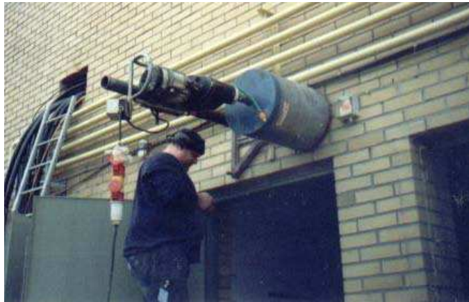
Figur 9. Håltagning med kärnborr (Källa: http://www.kallgrenosoner.se/bilder/betongs.jpg )
