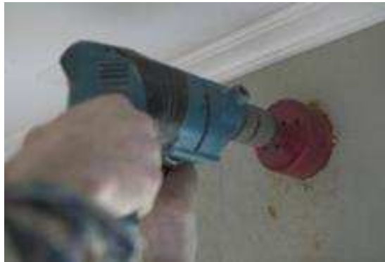
Figur 10. Håltagning med hålsåg (Källa: http://www.fresh.se/p78005/files/78152.jpg )
