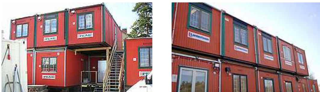
Figur 3a och 3b: En vanlig uppställning av bodar, med kontorsbodarna ovanpå personalbodarna. (Lambertsson 1)
