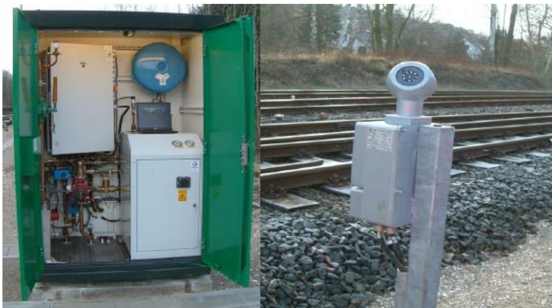
Figur 14: Växelvärmeskåpe och väderlekstation för geotermisk uppvärmning kan se ut enligt ovan. I skåpet kan man bland annat se delar av värmepumpen. En bärbar dator kan kopplas in för att på plats logga in och ändra inställningar (Frenzel 2007c/ Frenzel 2007d).
