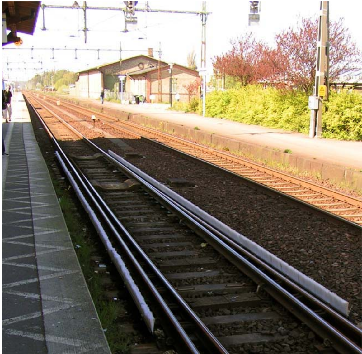
Figur 9: En växel på Ängelholms station i Skåne som är utrustad med borstar som skyddar mot drivsnö. I Skåne är drivsnö ett problem eftersom landskapet mestadels är flackt.
