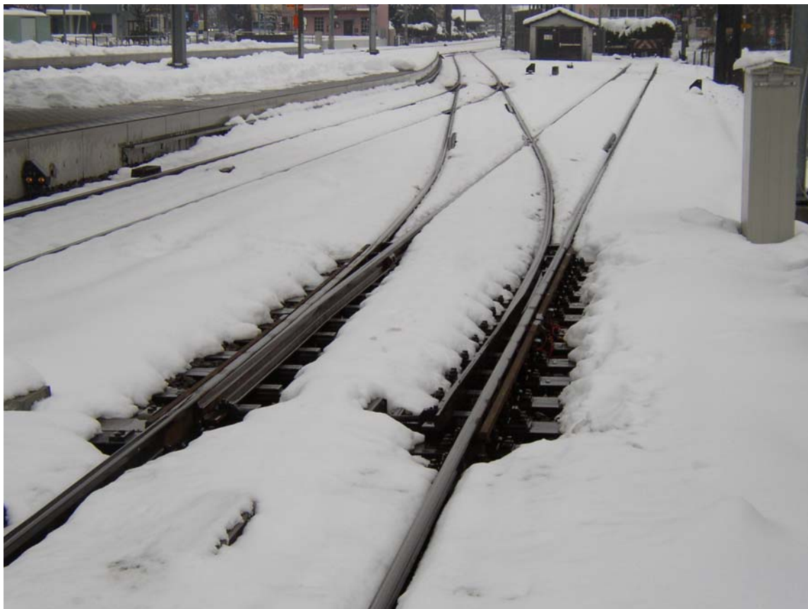
Figur 10: En tysk gasdriven växelvärmearläggning med infraröd princip som värmer växelutgången. Gasvärme föredras i Tyskland i regioner med extrem nederbörd eftersom den har en tredubblad effekt jämfört med elektriska anläggningar.
