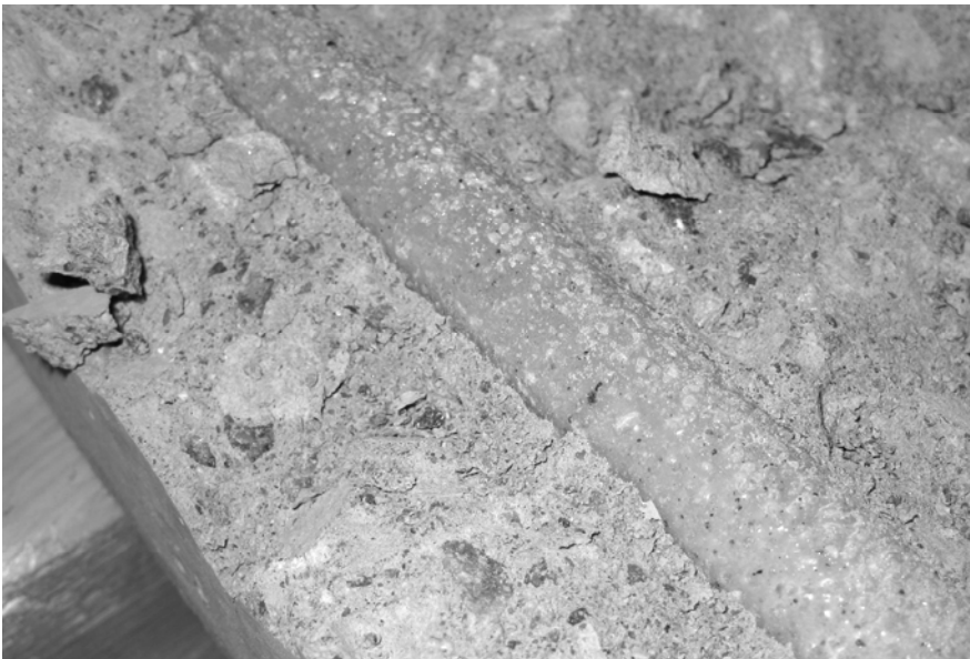
Fig 5.4 Glasfiberarmering i balk efter test. Ytstrukturen är fortfarande intakt.
