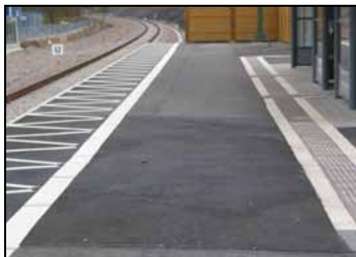
Figur 110 Markering och ledstråk på plattformen
