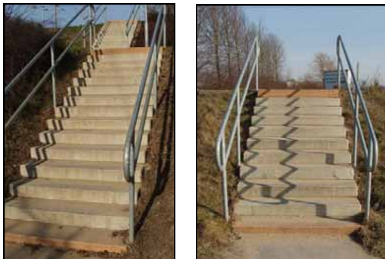
Figur 87 Trappor med markeringar på Burlövs station
