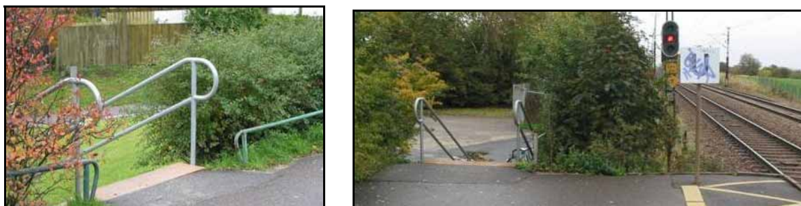
Figur 48 Södra (t.v.) och norra trappan (t.h.) på plattformen för resenärer mot Lund
