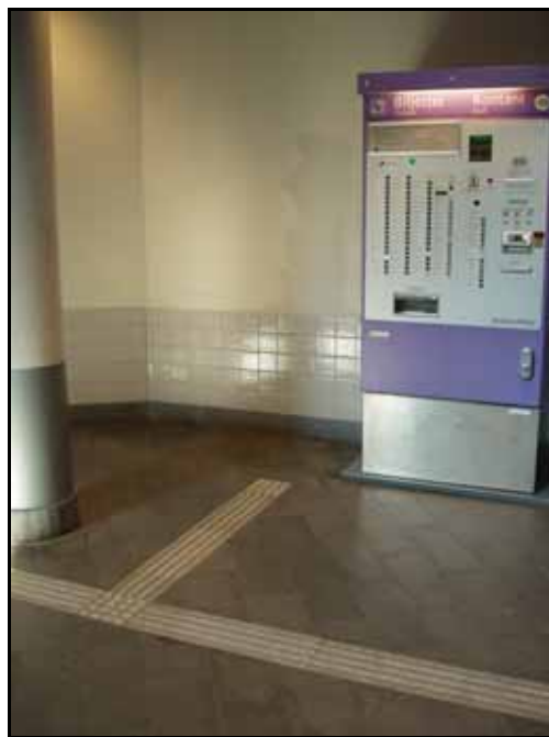
Figur 103 Ledstråk till biljettautomater
