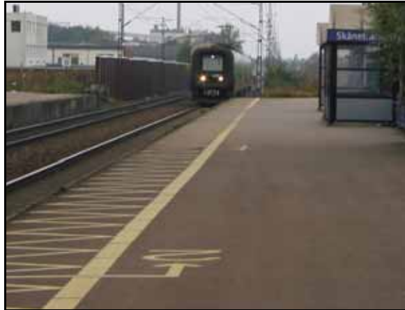
Figur 89 Gul markering som anger säkerhetsavstånd till perrongkanten
