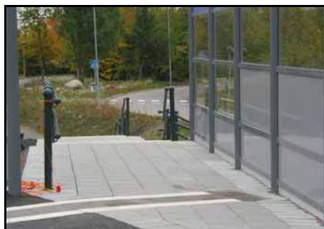
Figur 109 Trappor (t.v.) och ramp (t.h.) med tillhörande Ledstråk på Gunnesbo station
