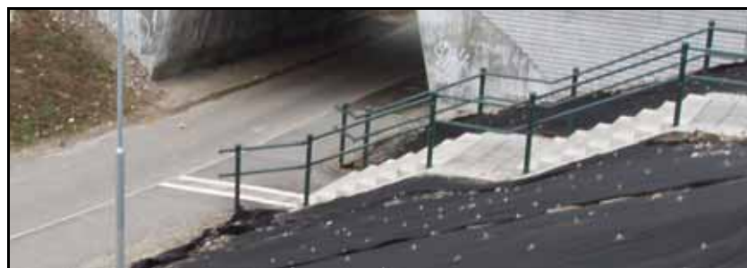
Figur 111 Ledstråk från trappa till kantsten
