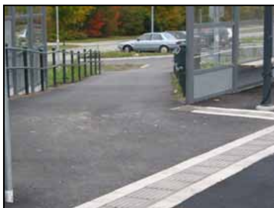
Figur 3 Sinusplattor på Gunnesbo station
