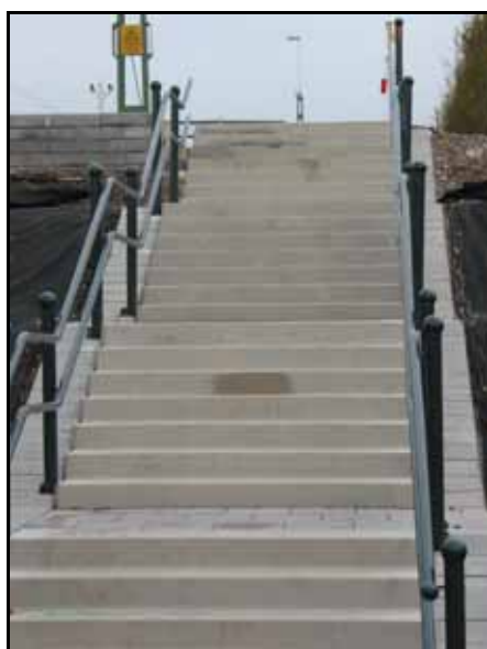
Figur 113 Trappa vid Gunnebo station
