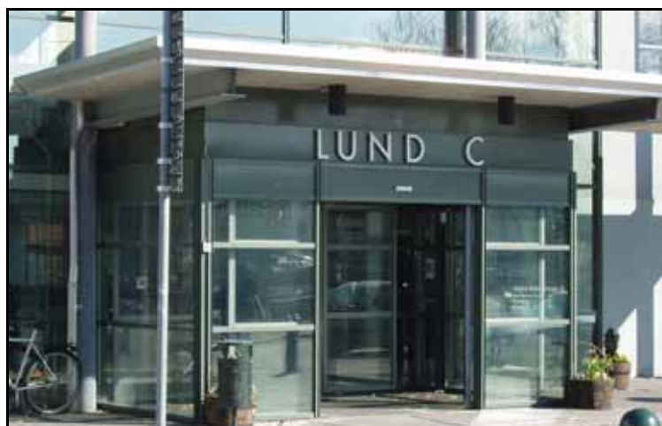
Figur 58 Entré intill västra stationstorget
