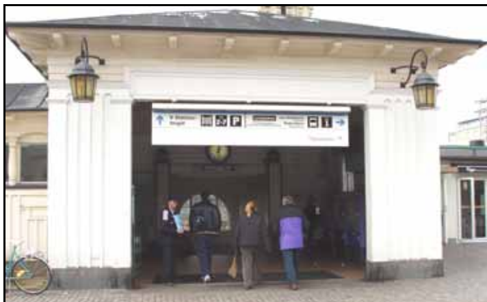
Figur 59 Norra entrén vid Bangatan
