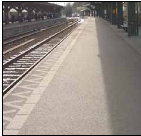
Figur 107 Plattformskanten är dåligt markerad
