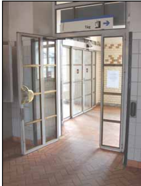
Figur 62 Dörr som öppnas med knapp på väggen
