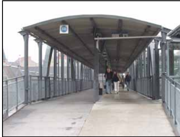
Figur 104 Gång- och cykelbro på stationen i Lund
