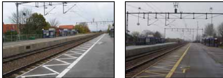
Figur 93 Olika färg på varningsmarkeringarna vid plattformskanten
