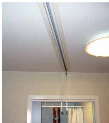
Figur 4.6. Human Care Lifts skensystem, då skenan integreras i taket.
